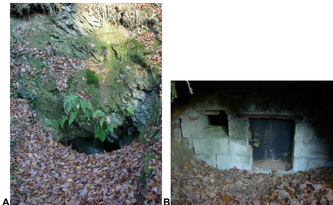
Figure 3 : Galerie du « Thier-Al-hèt » à Grupont. A : vue générale; B : vue de l'accès sécurisé dans l'abri sous-roche. Photos : M. Blondieau (novembre 2020).
